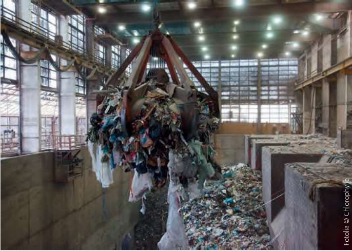
Bunker za otpad
